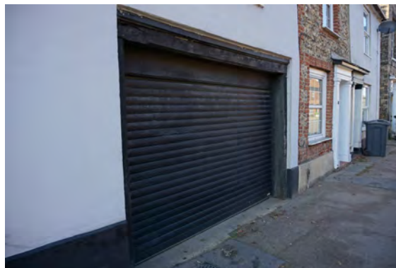
Inserted garage door
