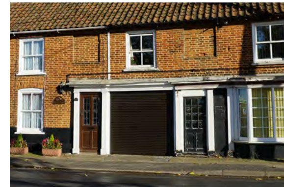
Inserted garage door
